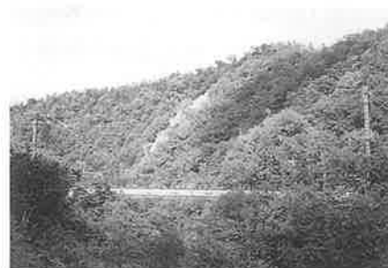
写真-4 補剛桁架設完了
