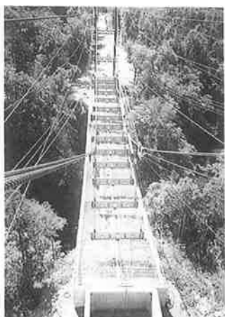
写真-2 床桁架設
