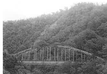
写真-5 アーチ架設
