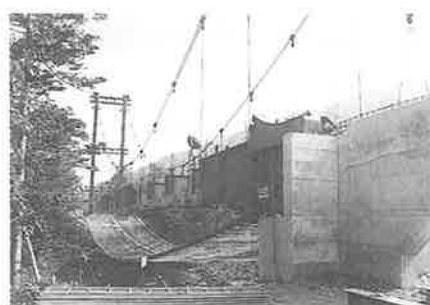
写真-3 補剛桁架設
