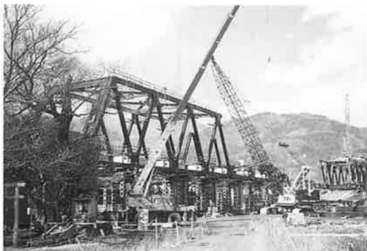
写真-6 架設（ベントクレーン工法）
