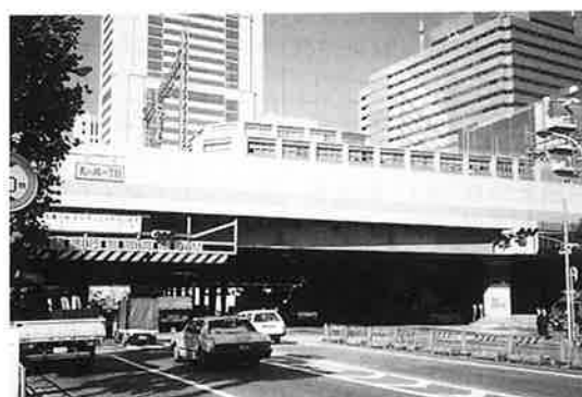
写真-7 単スパン橋梁 東北新幹線呉服橋架道橋 (支間長42.25m 道床式合成桁 1988年)
