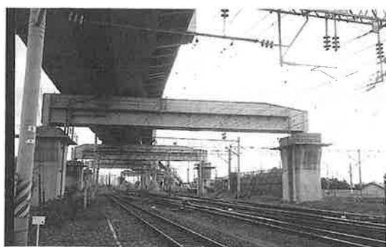
写真-15 鋼受桁を用いた東北新幹線盛岡こ線線路橋 (支間長4×44.8m 道床式合成桁 1977年)
