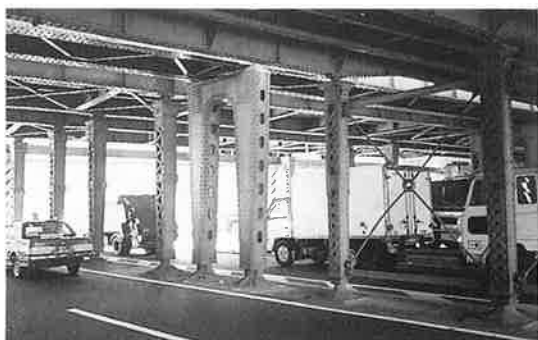
写真-1 建設年代によって構造の異なった鋼柱が建ち並んだ東京駅付近の鍛冶橋架道橋
