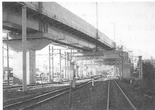
写真-8 鉄筋コンクリート橋脚・鋼受桁を用いた橋梁 東北新幹線盛岡こ線線路橋 (1977年)
