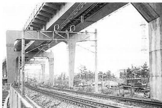
写真-12 鋼ラーメン橋脚を用いた山陽新幹線遠石線路橋 (支間長4×34.15m 道床式合成桁 1972年)
