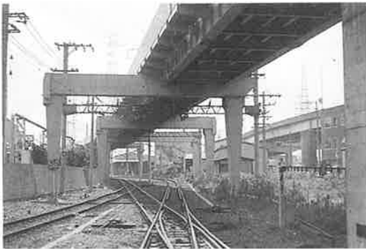
写真-14 ラーメン隅角部に引張ボルト接合を用いた鶴見線鶴見線路橋 (支間長6×25.3m 道床式バックルプレート下路プレートガーダー 1971年)
