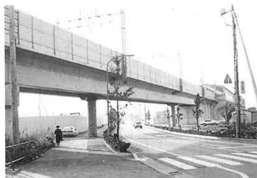
写真-10 鋼橋脚を用いた東葉高速線白筋架道橋 (支間長19.95+44.2+19.95m 道床式3径間連続 部分合成桁 1993年)
