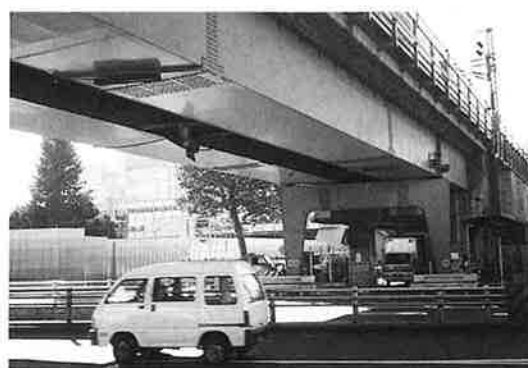
写真-11 鋼ラーメン橋脚を用いた東海道新幹線鍛冶橋架道橋 (支間長6.4+27.4+7.4m 道床式合成桁 1962年)
