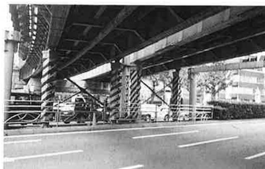
写真-2 鋼柱を用いた中央線万世橋架道橋 (支間長23.6+35.3m 道床式下路プレートガーダー 1928年)
