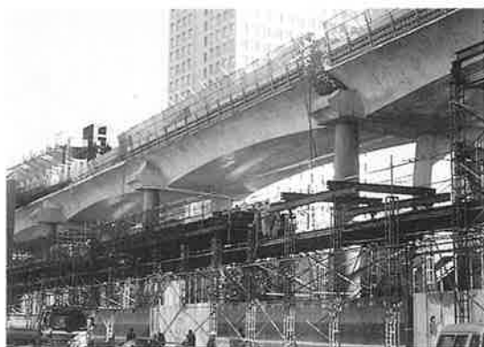
写真-21 中央線東京駅付近重層化高架橋
