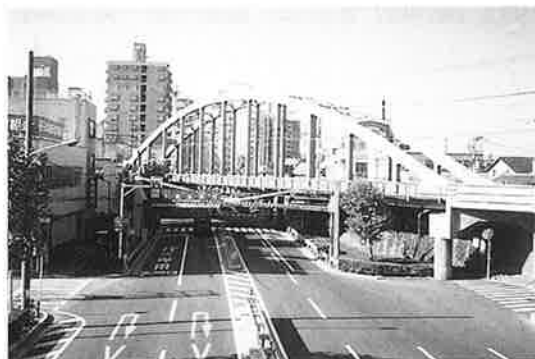
写真-5 単スパン橋梁 常磐線第3三河島架道橋 (支間長68.0m 開床式下路ローゼ桁 1967年)
