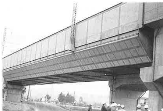
写真-6 単スパン橋梁 東北新幹線オノ馬場架道橋 (支間長56.75m スラブ軌道式合成桁 防音工付 1978年)
