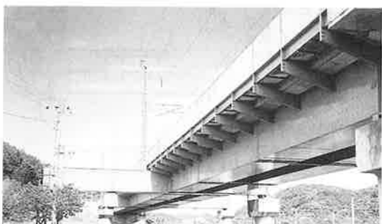
写真-16 鋼受桁を用いた山陽新幹線関口架道橋 (支間長3×36.0m 道床式合成桁 1973年)
