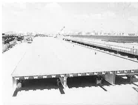
写真-1 鋼床版仮組立
