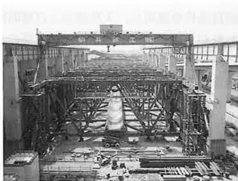
写真-2 補剛桁仮組立
