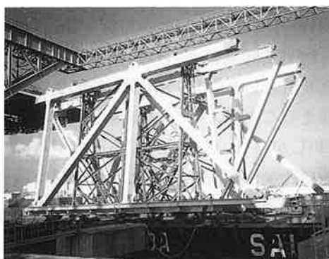
写真-5 補剛桁出荷
