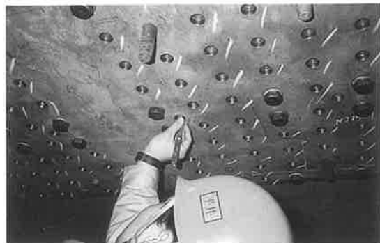
写真-3 メタルタッチの計測
