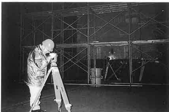
写真-2 部材の倒れの計測
