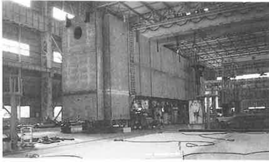
写真-4 塔頂水平材の仮組立検査
