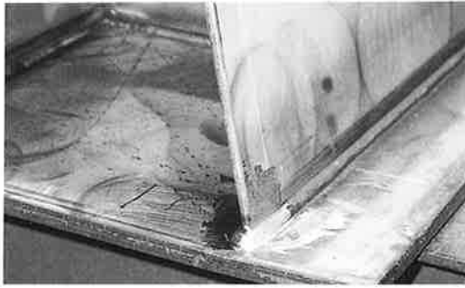
写真-2 トラフリブのまわし溶接
