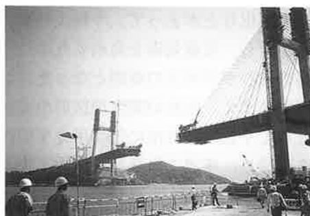
写真-4 汲水門大橋の架設
