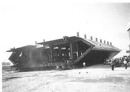
写真-3 地組立場におけるドーリーによるブロックの搬送(青馬大橋)
