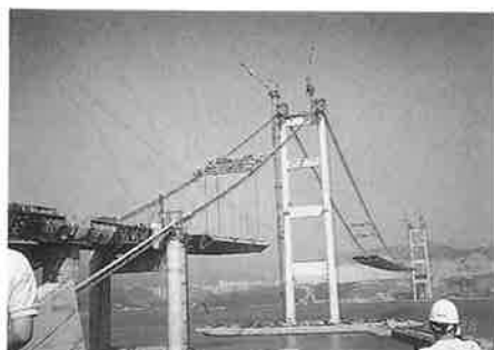
写真-1 青馬大橋の架設
