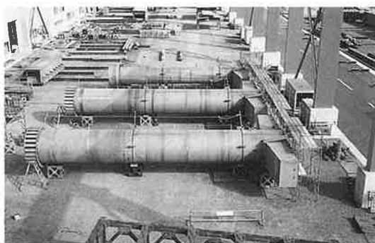
写真-16 復旧第18工区 T型橋脚の仮組立
