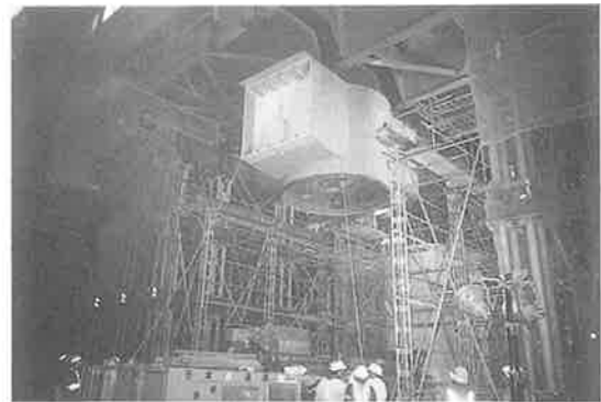
写真-12 復旧第11工区 鋼製梁の架設(その1)
