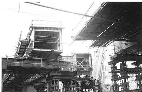
写真-7 座屈ブロック撤去後状況
