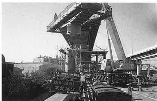
写真-18 復旧第18工区 T型橋脚(梁)の架設
