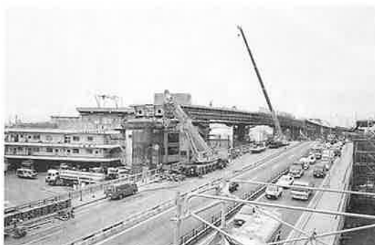
写真-20 復旧第18工区 上部工の架設(その2)
