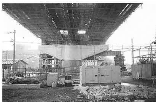
写真-22 復旧第24工区 現場状況(その2)
