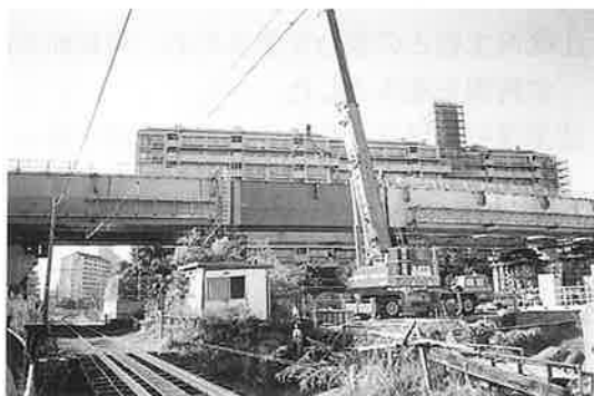
写真-8 再構築ブロック架設後状況
