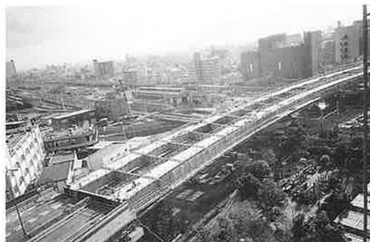
写真-21 復旧第24工区 現場状況(その1)
