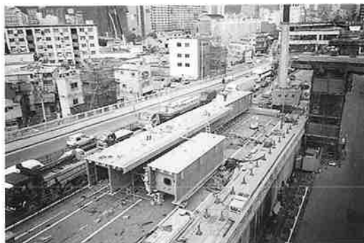
写真-19 復旧第18工区 上部工の架設(その1)
