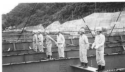
写真-5 橋体の振動試験(加振状況)
