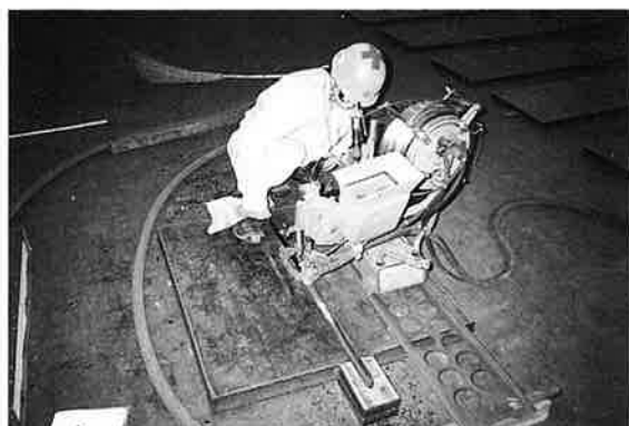
写真-1 開先形状選定試験
