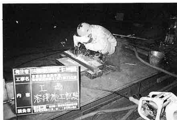
写真-3 突合せ溶接試験状況
