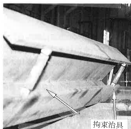
写真-2 拘束治具取付状況
