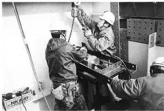
写真-17 ピン挿入状況
