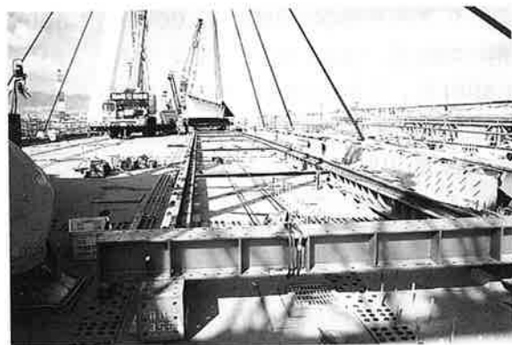
写真-10 運搬状況
