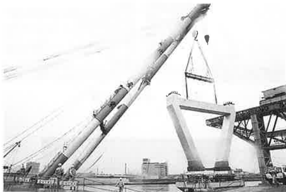
写真-12 塔基部架設状況
