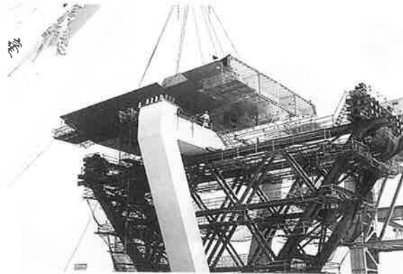
写真-4 斜ベント
