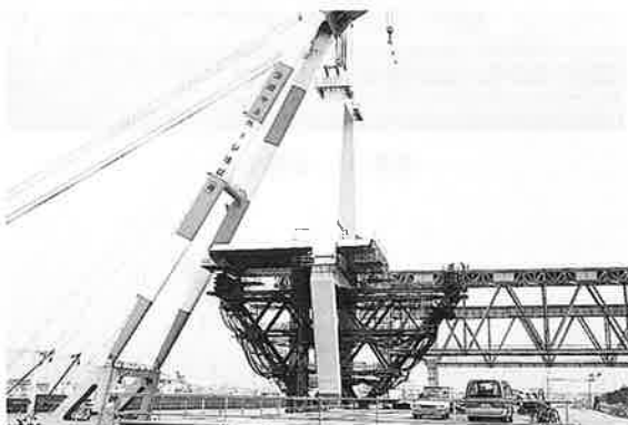
写真-14 塔中段の架設
