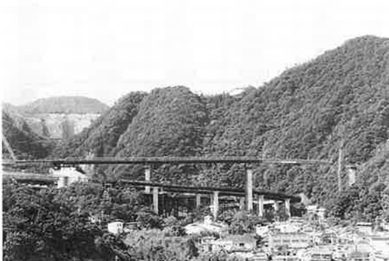
写真-3 送出し状況
