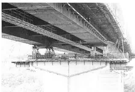
写真-5 桁降下状況
