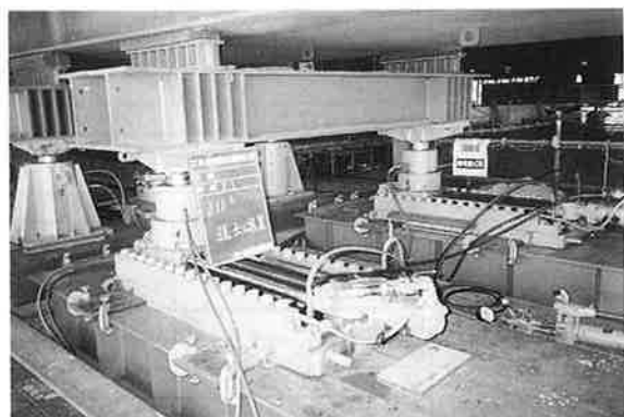
写真-4 送出し装置
