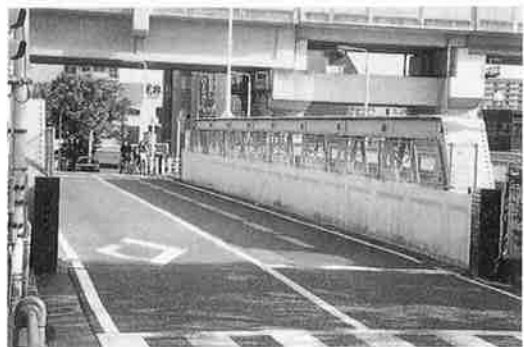
写真-2 十条跨線橋（トラス製作1895(明治28)年）
