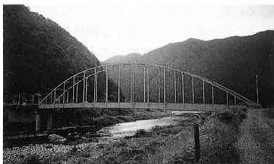
写真-1 津伏橋の全景
