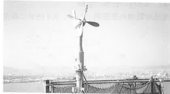
写真-2 塔頂に設置したプロペラ式風向風速計
