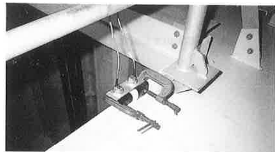
写真-3 塔内に設置した加速度センサー
