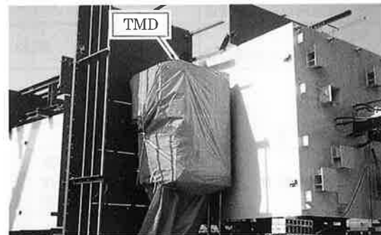
写真-1 塔地組立時のTMDの設置状況 (オーニング処理後)
