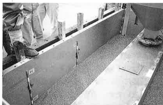
写真-1 打設中のコンクリートのレベリング状況
