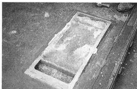
写真-3 蓋タイプの打ち上がり後
