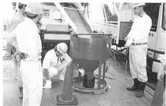
写真-6 コンクリート打設状況
