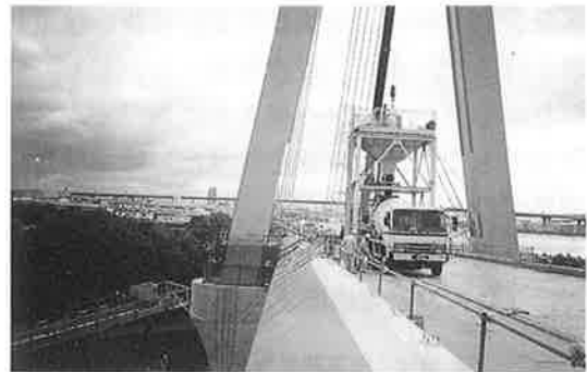
写真-5 橋面上中間ホッパー
