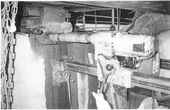
写真-1 支承撤去状況
