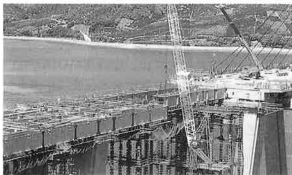
写真-2 A橋の架設状況
