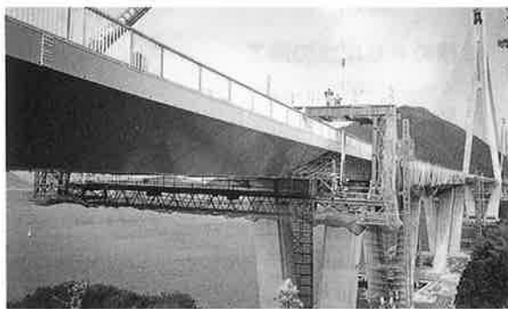
写真-4 A橋の移動防護工
