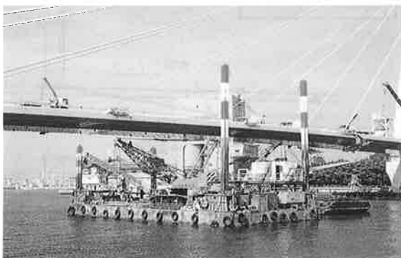
写真-3 ベント杭の撤去状況
