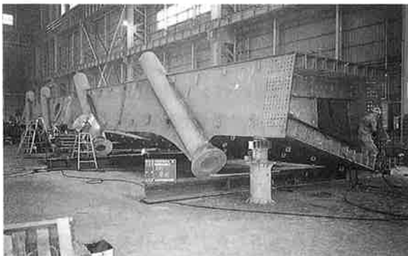
写真-1 ケーブル定着部主桁
