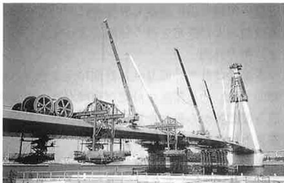
写真-6 ケーブル架設状況
