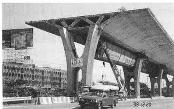
写真-4 セグメントの架設
