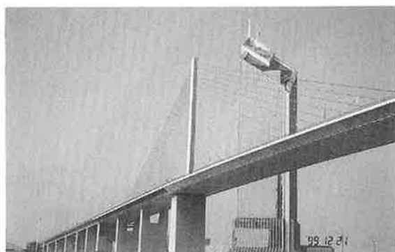
写真-6 ラマ9世橋
