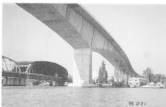
写真-10 ラマ 8 世橋
