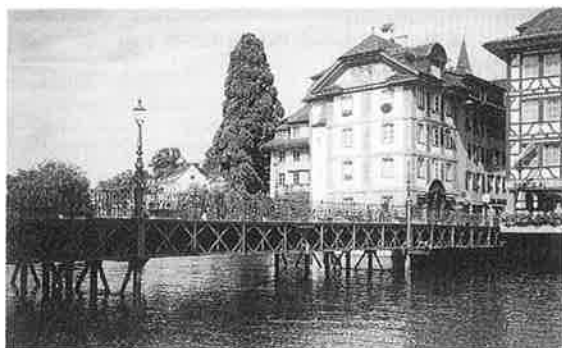
写真-4 ロイス橋
