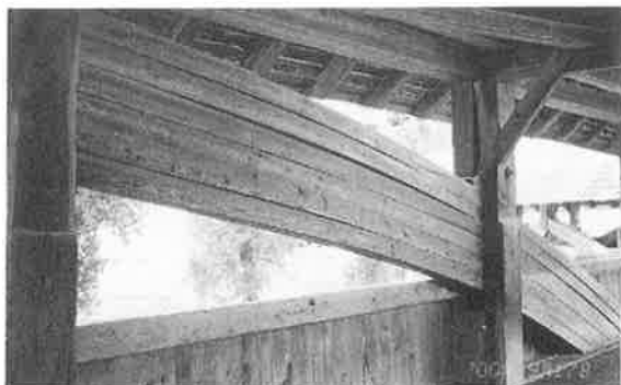
写真-3 橋上からみたアーチ部材
