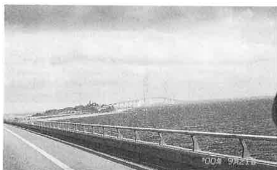
写真-5 グレートベルトイースト橋
