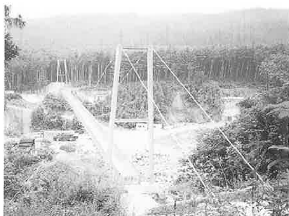
写真-1 横川砂防公園吊橋全景
