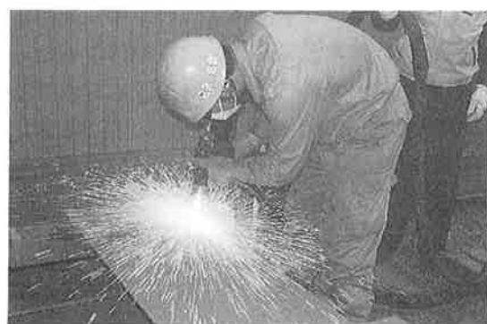
写真-5 アモルファス合金溶射状況
