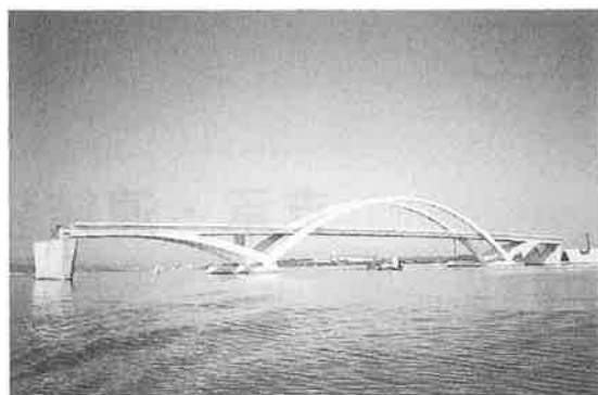
写真-4 完成写真
