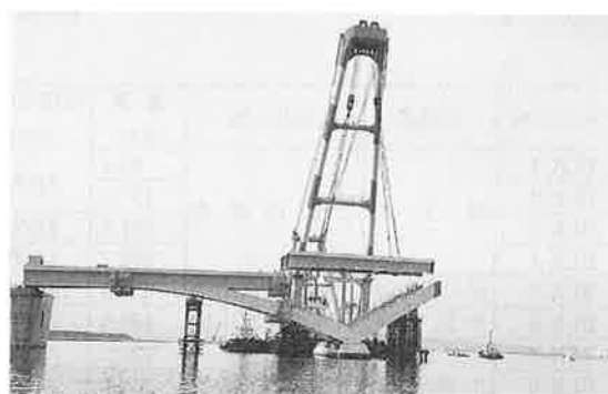
写真-1 側径間架設状況
