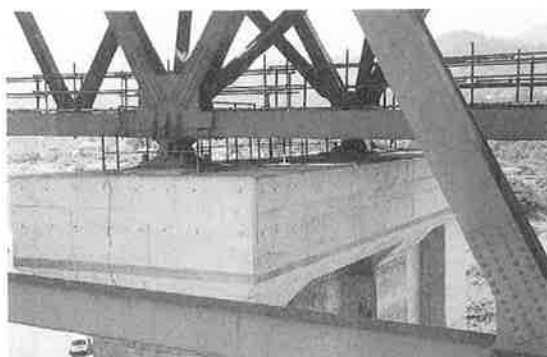
写真-2 橋脚天端の拡幅
