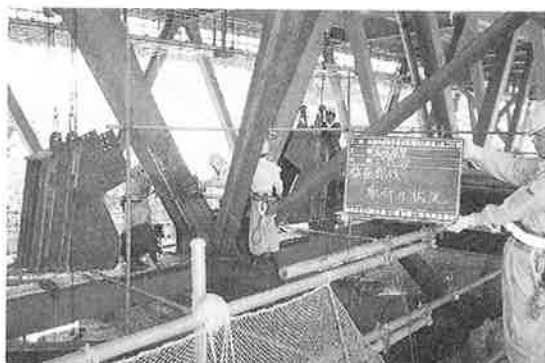
写真-4 補強部材の取り付け
