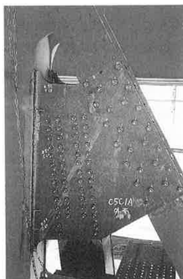
写真-14 端支点ジャッキアップ補強
