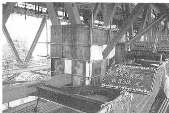
写真-6 現場溶接時の防風設備
