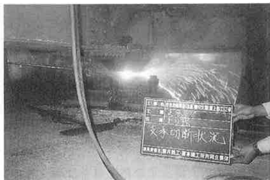
写真-10 酸素溶断による支承の撤去
