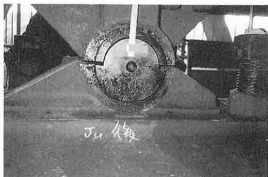
写真-9 ジャッキアップ量3mm
