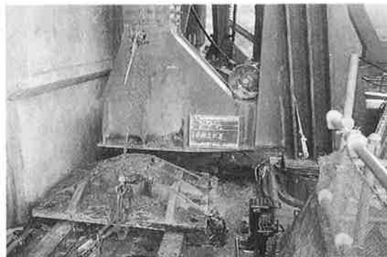
写真-15 端支点部支承撤去
