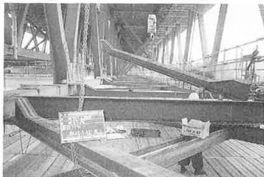
写真-3 中間支点部下横構の組替
