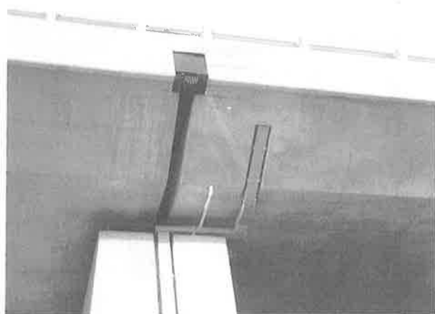
写真-1 排水管の設置
