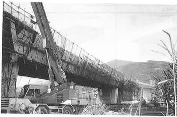
写真-3 鋼桁部のシート養生
