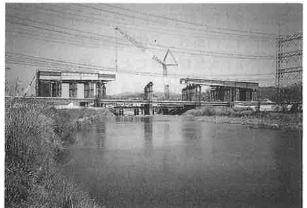
写真-2 4P118-4P119中央径間の架設
