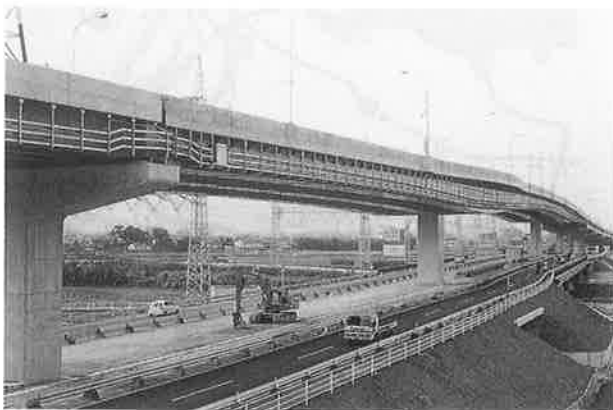
写真-3 完成写真
