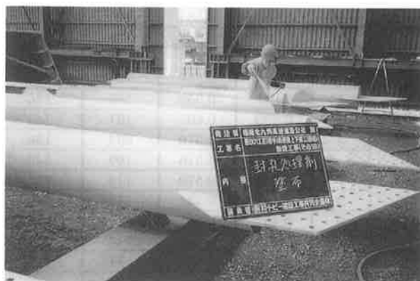
写真-9 封孔処理（横桁）
