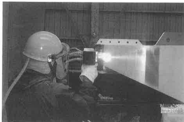
写真-8 金属溶射（縦桁）
