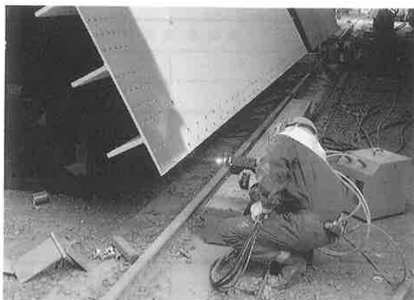
写真-7 金属溶射（主桁）
