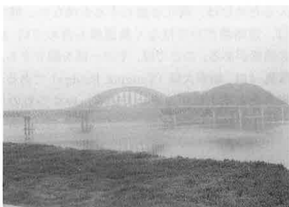
写真-7 傍花大橋
