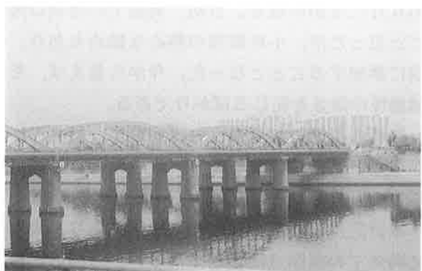
写真-5 漢江大橋
