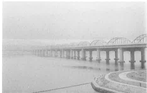
写真-4 銅雀大橋
