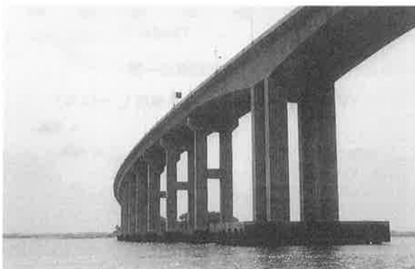
写真-3 西海大橋（PC橋部）
