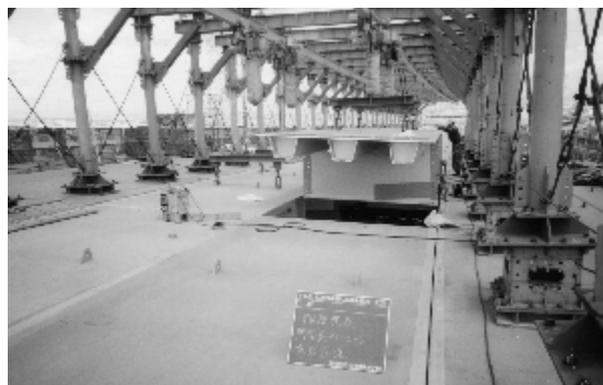
写真-4 走行クレーンによる中床版の架設
