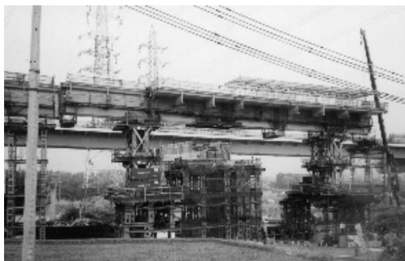
写真-3 ジャッキアップ工法による架設
