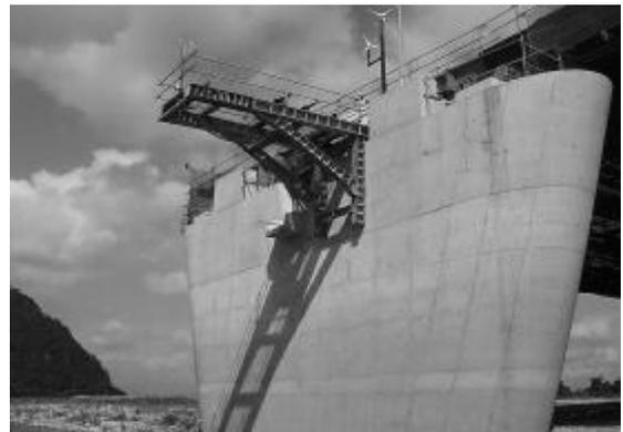
写真-2 観測機器設置状況(橋脚側面)
