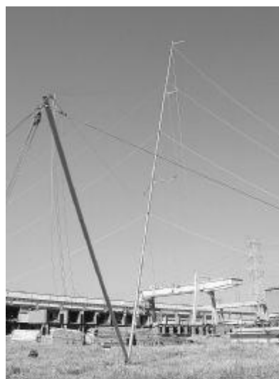
写真-1 観測用ポール設置状況（立ち上げ）
