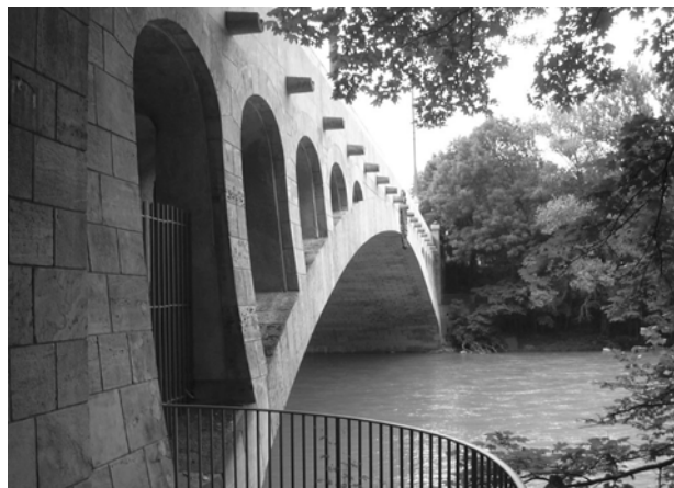
写真-10 マルティウス通りの橋
