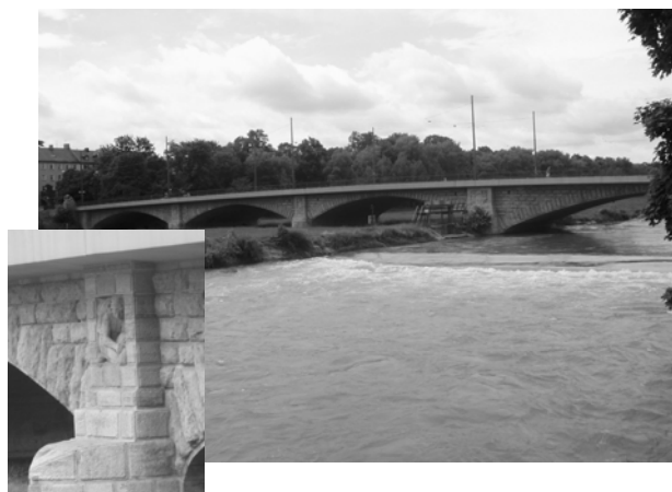
写真-3 オルムオレル通りの橋 連続アーチ橋。橋脚部に彫刻がある。
