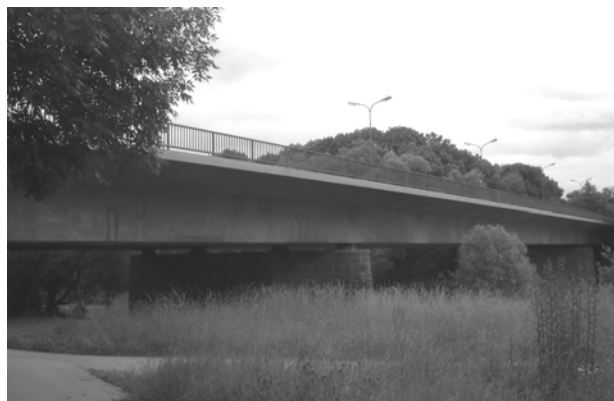
写真-11 幹線道路の橋
