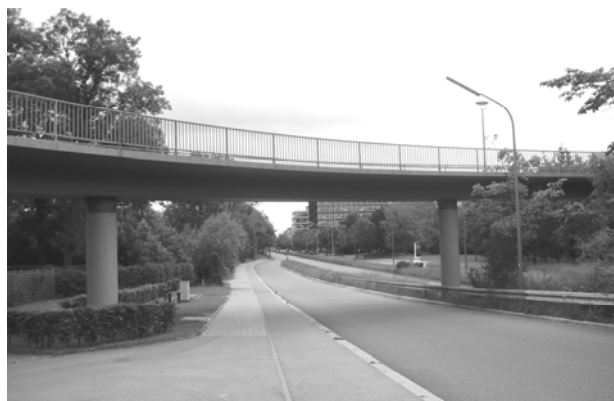
写真-12 イギリス公園への歩道橋
