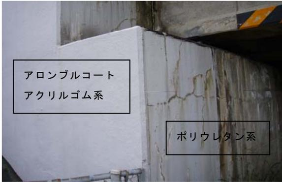
写真-4 北陸道コンクリート表面保護材の比較
