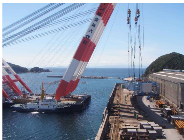
写真-6 浜出し状況（Aブロック）
