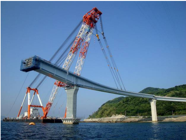
写真-7 Aブロック架設状況（曲線区間）
