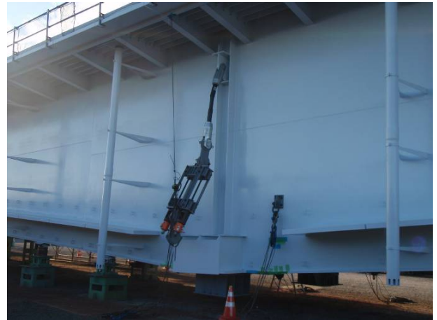
写真-8 転倒防止装置（P6橋脚部）
