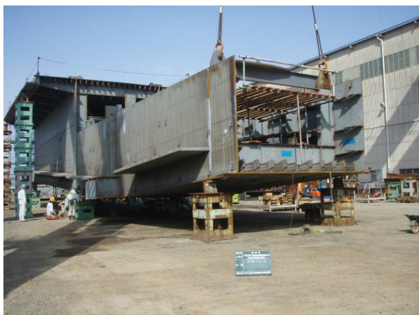
写真-2 仮組立状況（Aブロック：P6中間支点部）
