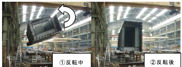
写真-1(b) 工場内反転状況（中間支点下側ブロック）
