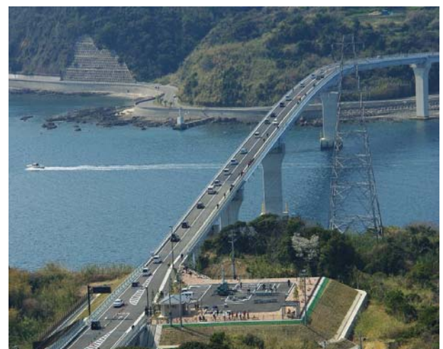
写真-10 伊王島大橋（完成写真）
