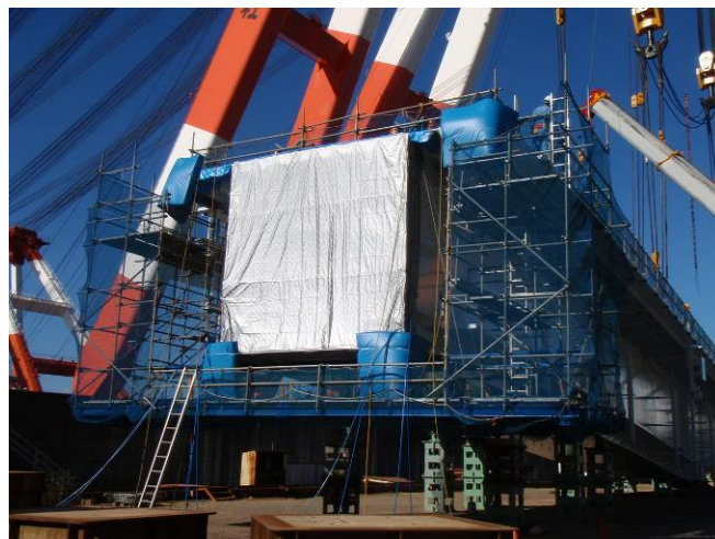
写真-5 オーニング状況（Aブロック）
