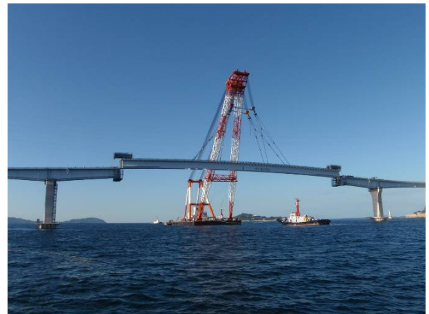
写真-9 Bブロック架設状況（セッティングビーム）
