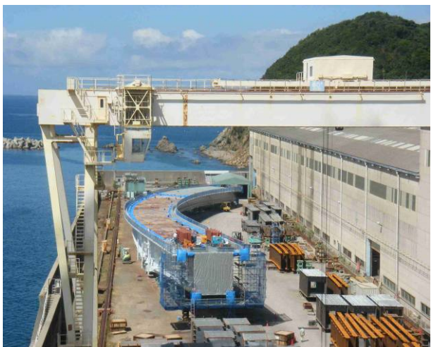
写真-4 地組立全景（Aブロック）
