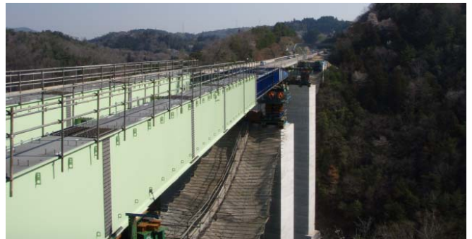
写真-2 送り出し架設状況
