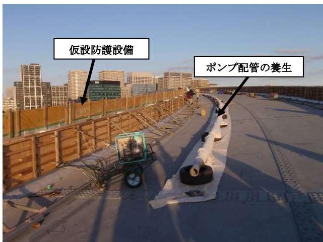
写真-10 ポンプ配管の養生
