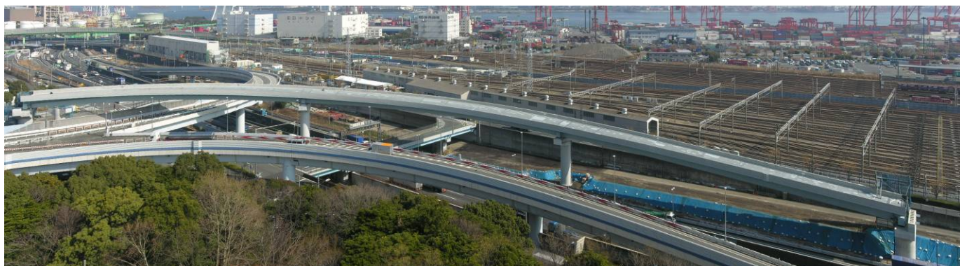
写真-13 工事完了全景
