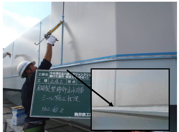
写真-9 鋼製型枠外側の止水コーキング状況
