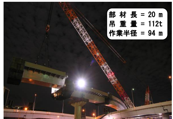
写真-4 (写真-3 ③~⑤)1250t吊クローラークレーン一括架設
