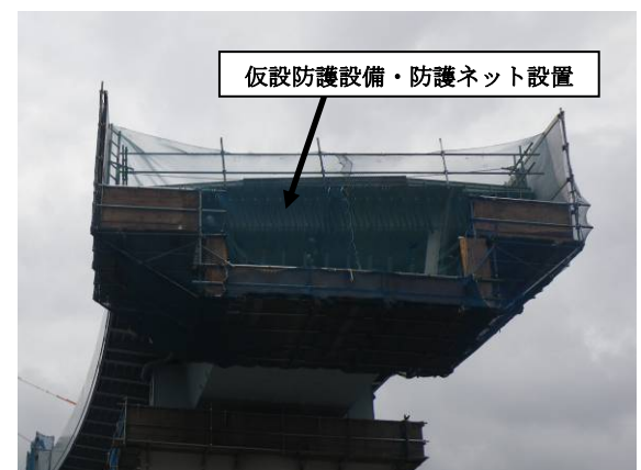
写真-6 落下物防止対策
