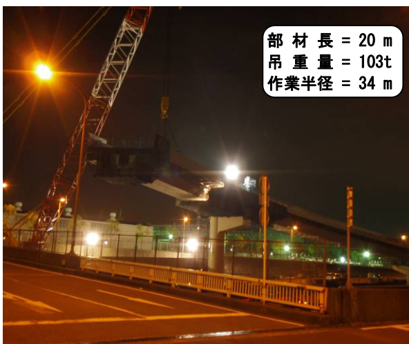
写真-5 (写真-3 ⑥~⑦)800t吊クローラークレーン一括架設
