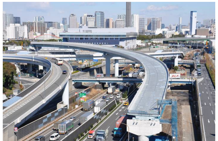
写真-2 完成状況
