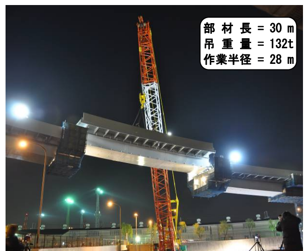
写真-5 (写真-3 ⑥~⑦)800t吊クローラークレーン一括架設
