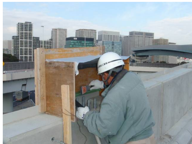
写真-12 アンカー箱抜き部 防護設備
