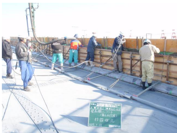
写真-11 壁高欄コンクリート打設状況
