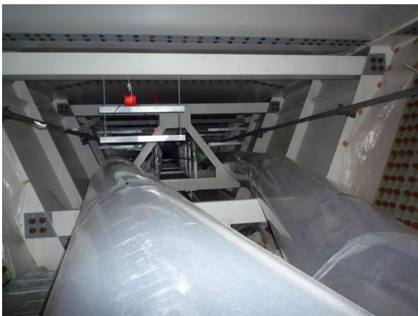
写真-4 箱桁内ポリダクト配置
