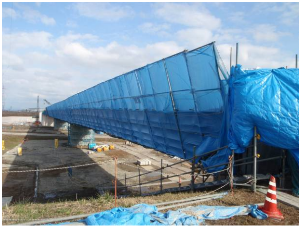
写真-2 朝顔足場シート養生
