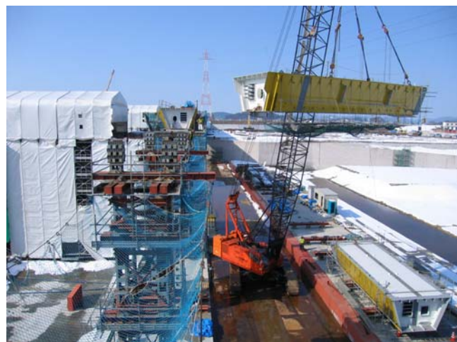
写真-1 架設状況写真
