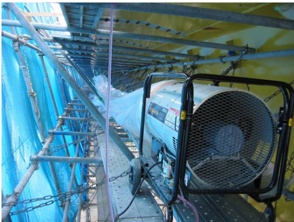
写真-3 張出部ジェットヒーター配置
