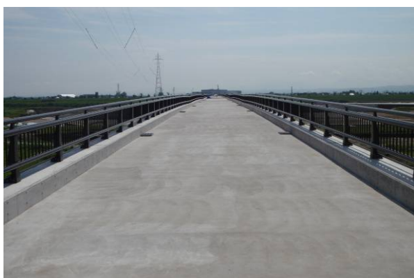
写真-6 施工完了
