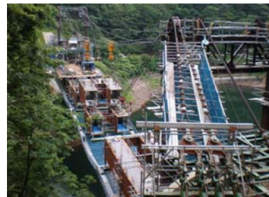
写真-1 桁架設状況
