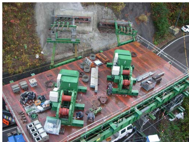
写真-8 県道防護工上ウィンチ設置状況
