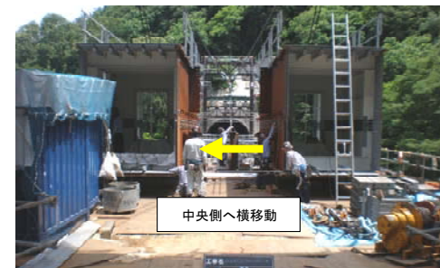
写真-3 横移動状況（A2 から A1 を臨む 横移動完了）
