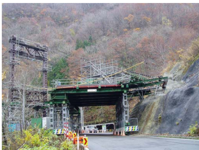
写真-7 県道防護工
