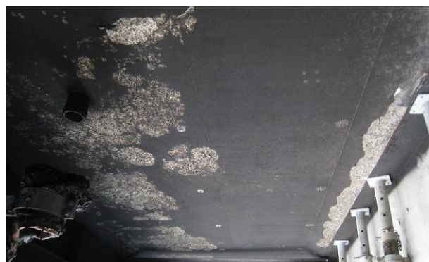
写真-5(a) 床版コンクリートの変状(すずの付着)
