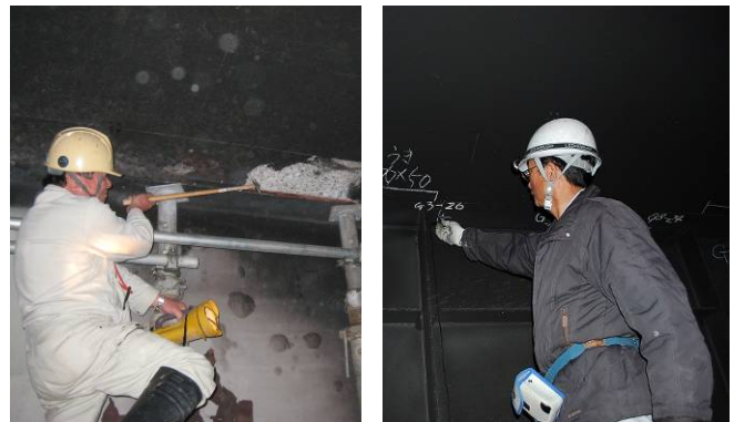
写真-12 床版コンクリートの変状調査
