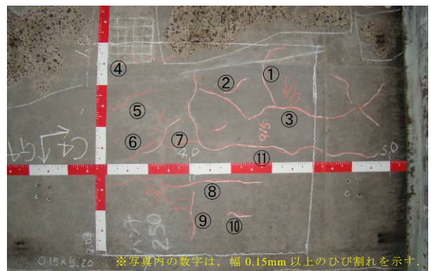
写真-13 ひび割れ密度の調査
