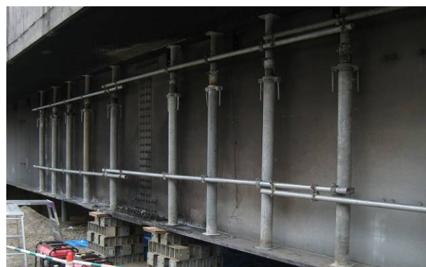
写真-8 仮受ベントとパイプサポート
