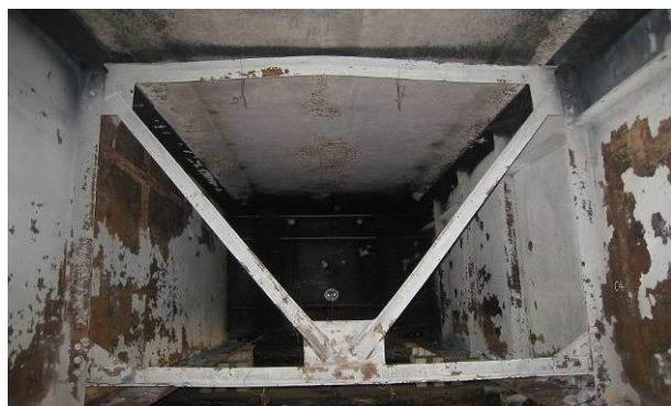
写真-4 対傾構の変形
