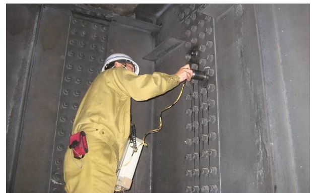
写真-15 超音波を用いたボルト軸力測定
