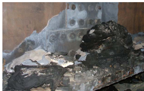
写真-2 主桁連結部の燃烧物
