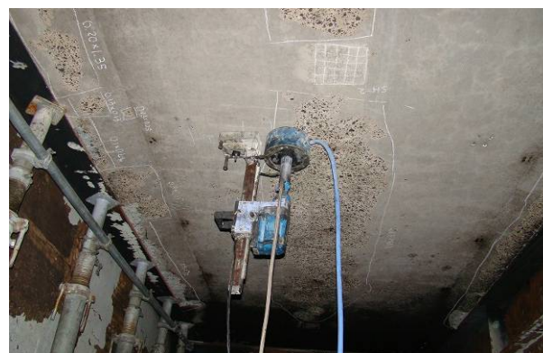
写真-10 コア採取による床版の圧縮強度試験
