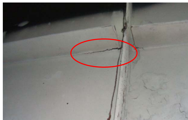
写真-1 溶接部のき裂（水平補剛材）
