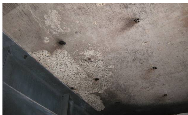
写真-5(b) 床版コンクリートの変状(すずの消失)
