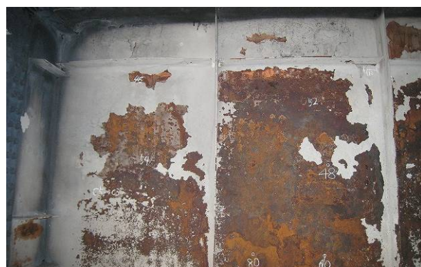
写真-7 溶射皮膜の炭化，消失
