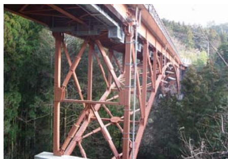
写真-1 全景（工事完了時）
