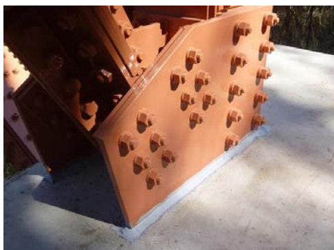
写真-13 シール施工状況
