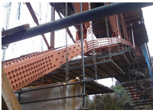
写真-6 当て板補強完了写真
