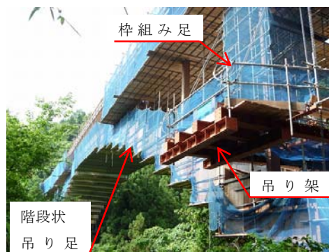
写真-5 足場設置状況
