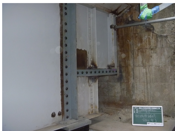
写真-15 桁端部補修状況
