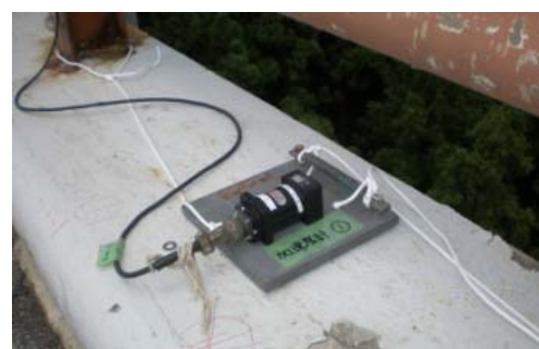
写真-2 計測状況（加速度計の設置）
