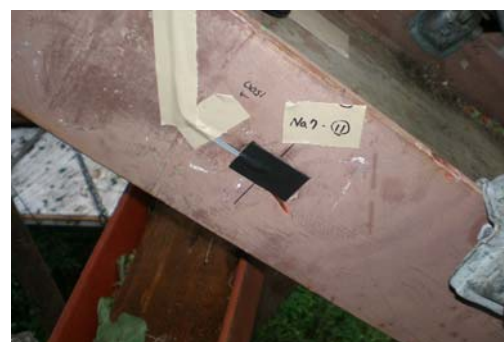
写真-4 歪みゲージ設置状況
