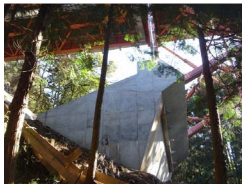
写真-12 アーチ支承固定化施工後
