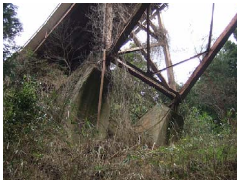
写真-11 アーチ支承固定化施工前
