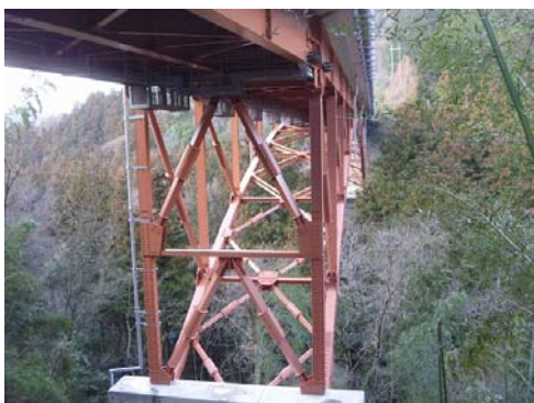
写真-9 耐震ブレースへの取替施工後
