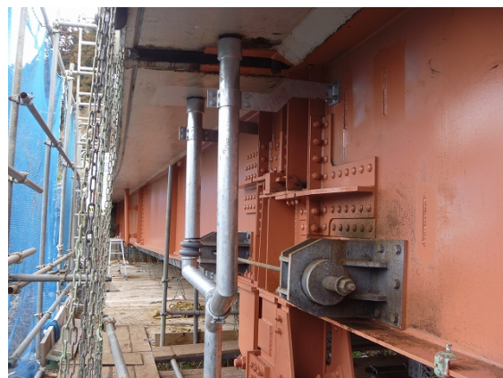
写真-18 排水管取替完了状況
