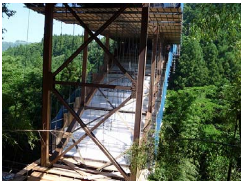
写真-8 耐震ブレースへの取替施工前
