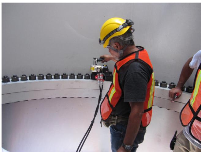
写真-6 タワー現場継手ボルト締付
