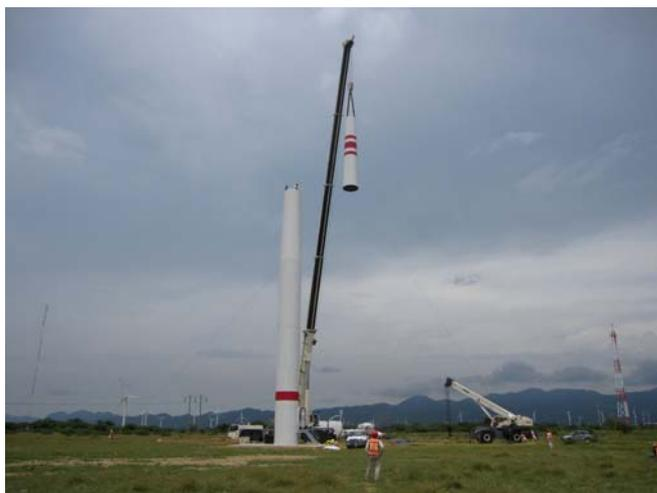
写真-5 タワーブロックの上架
