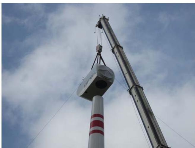
写真-7 ナセルの上架
