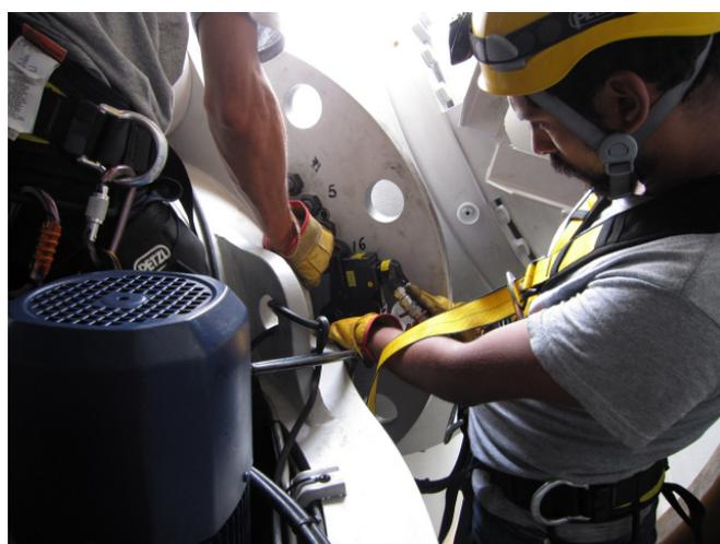
写真-11 定期点検的一幕（ボルト増し締め）
