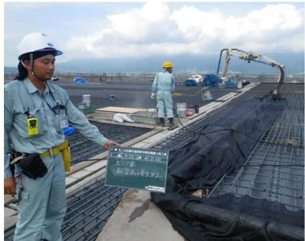
写真-1 配管部遮光ネット設置状況
