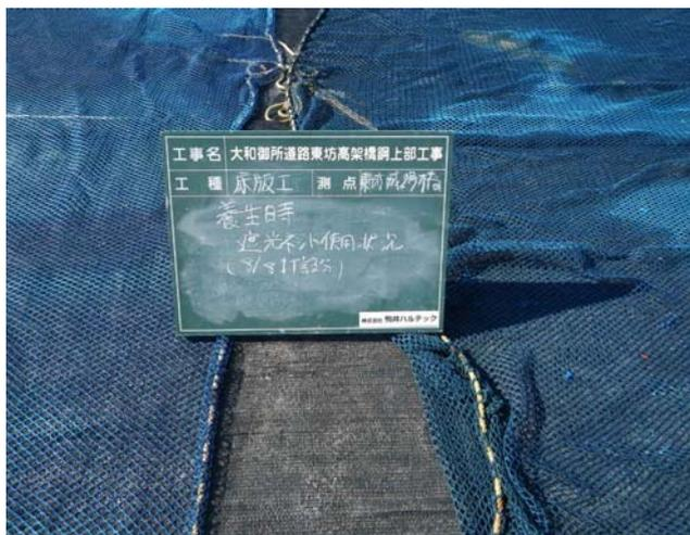
写真-3 コンクリート打設後養生状況
