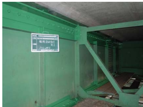
写真-9 補強部材設置完了状況
