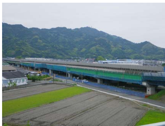
写真-10 全景（工事完了時）
