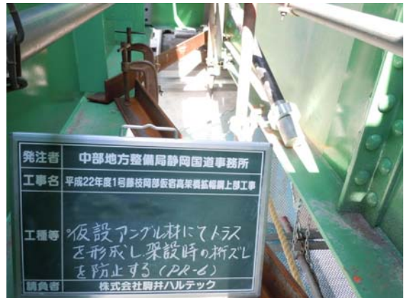
写真-6 仮設材によるトラス構造の形成
