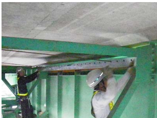
写真-8 補強部材設置状況
