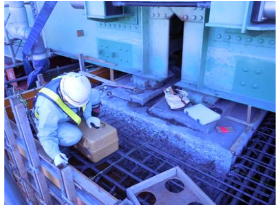
写真-5 沓座芯出し測量
