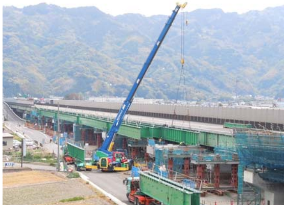
写真-2 新設桁架設状況
