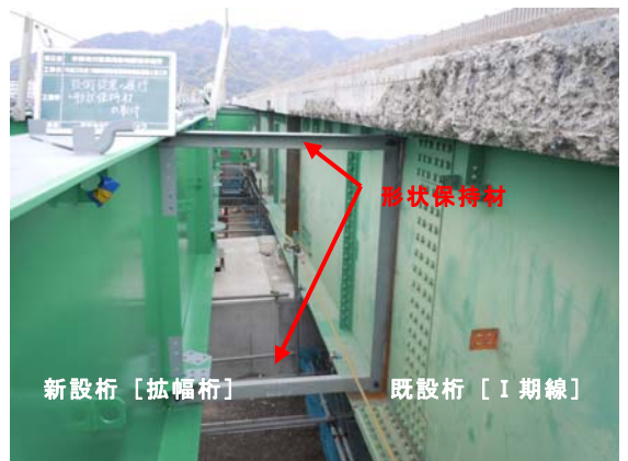
写真-7 形状保持材の設置
