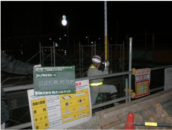
写真-3 縦断形状計測状況
