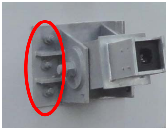
写真-1 樹脂系あと施工アンカー適用例 (落橋防止装置(らくらくブラケット))
