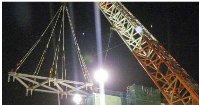
写真-10 撤去時施工性を考慮した吊り天秤
