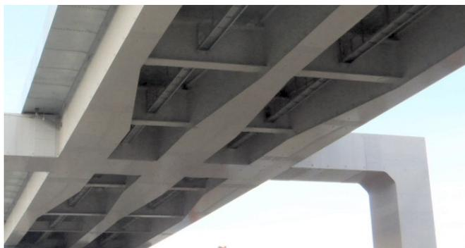
写真-2 本線橋脚部の拡幅構造
