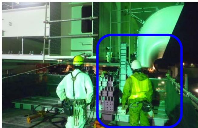
写真-11 架設ガイド・変位制限装置
