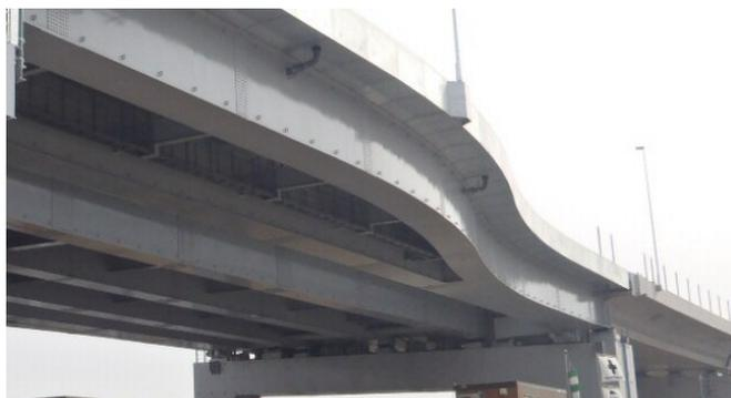
写真-1 ランプ橋の分岐構造
