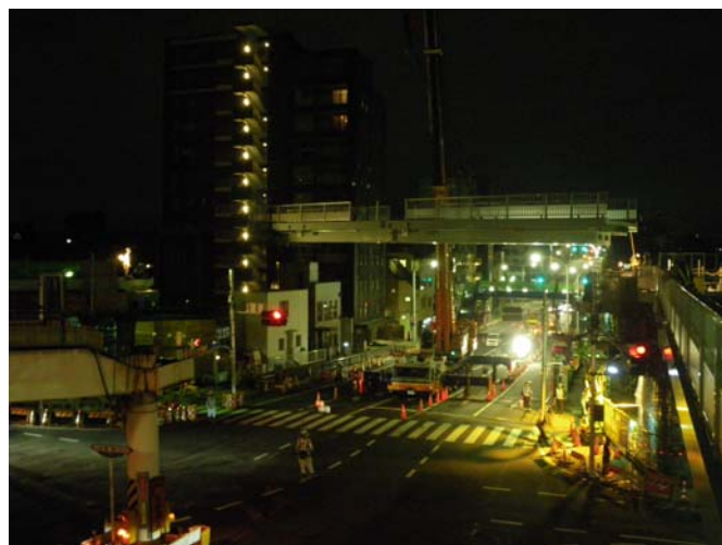
写真-2 一時通行止めが伴う架設状況
