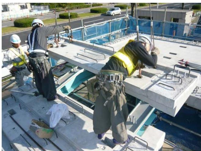
写真-5 階段プレキャスト床版架設状況
