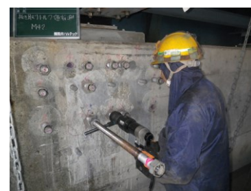
写真-2 抜き取り状況
